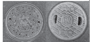
図2 鉄でできたマンホールのふた(左)とプラスチックでできたマンホールのふた(右)
